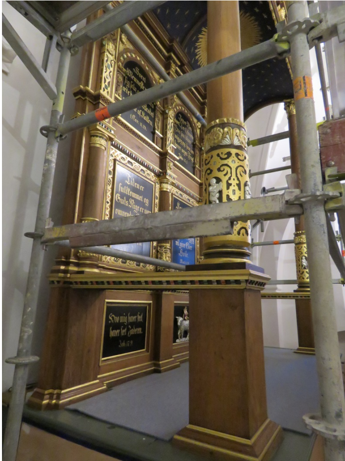
Altartavlen efter forsølvning og lasering. Foto: Nationalmuseet, Anja Liss Petersen.
