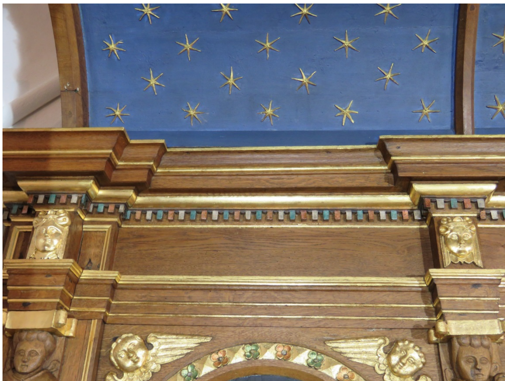
Øverste tandsnit efter lasering. Nederst i billedet ses blomsterne efter lasering. Foto: Nationalmuseet, Anja Liss Petersen.
